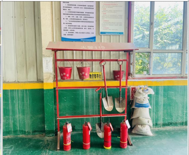
消防物资及防渗墙裙
